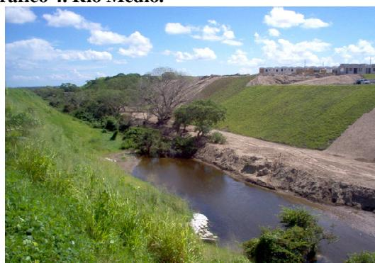
Río Medio, nótese la reducción del ancho del cauce por la terraza construida con arenas producto de la excavación.
