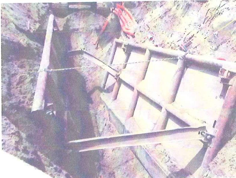
Por la presión de la tierra se flexiona una viga en la instalación de ademe así como a carreo de material al sitio indicado por la supervisión.
