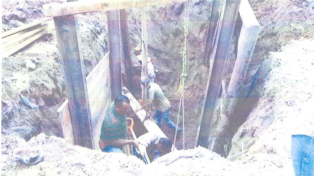
**Excavaciones a mano, apuntalamiento de tuberías existentes**
