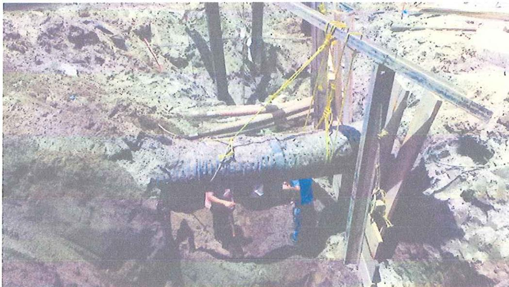
**Excavaciones a mano, apuntalamiento de tuberías existentes**
